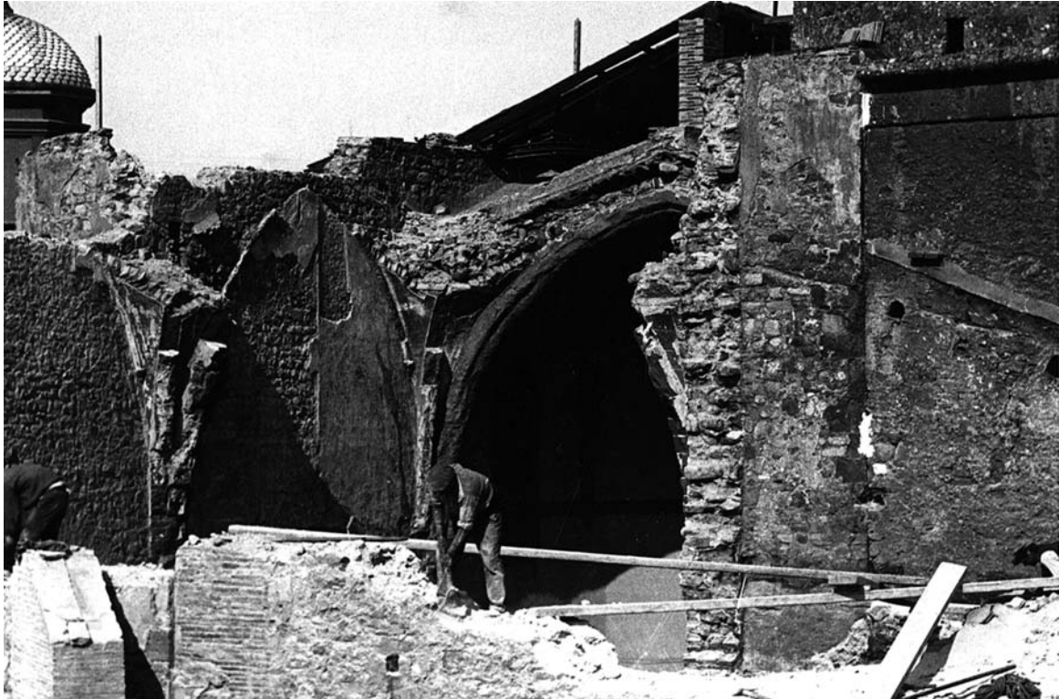
Foto 1 : Imatge de l'any 1910, després de l'ensorrada de l'església de St. Fèlix. S'observa el farciment de ceràmica i morter de la volta gòtica. (Arxiu Casanyes, MHS, negatiu vidre núm. 2759)
