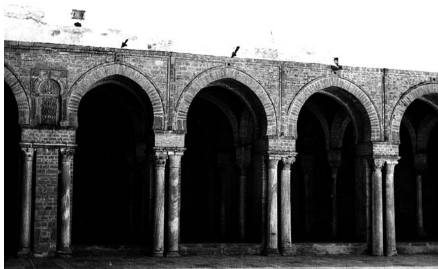
Fig. 6 : Mosquée Oqba de Kairouan : clous en céramique vernissée.
