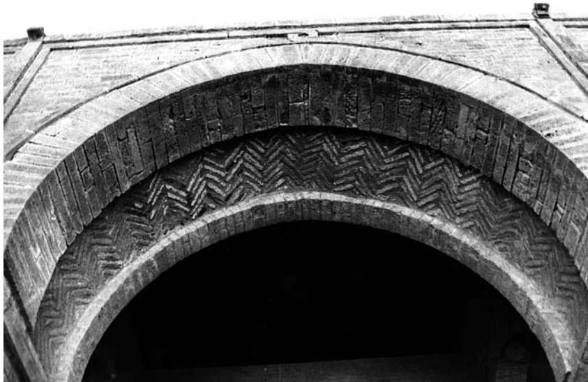
Fig. 2 : Mosquée Oqba de Kairouan : briques disposées en chevrons en décor d'intrados.
