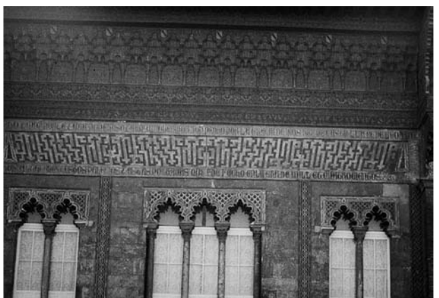
Fig. 3f : Detalles de la fachada del Alcázar de Sevilla.
