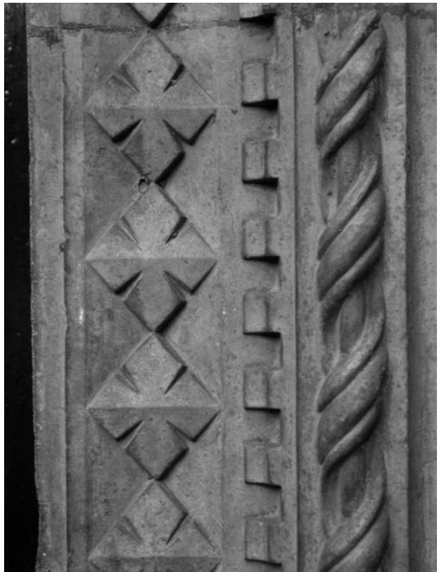
Fig. 13 : Particolare di un pezzo laterizio pressato in una cornice di un palazzo di Camporgiano (LU) degli inizi del secolo.
