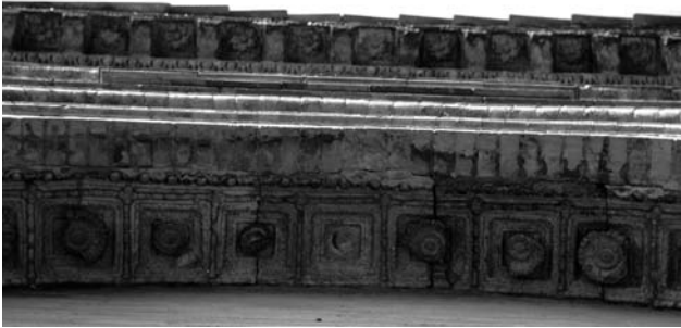
Fig. 9 : L'intradosso dell'arco della Cappella di Palazzo dei Diavoli a Siena (fine del XV secolo). Le grandi rosette sono applicate dopo cottura in incavi preparati nei lacunari dei grandi pezzi laterizi.
