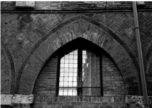
Fig. 10 : Muratura decorativa a spina-pesce tra la cornice e l'estradosso delle aperture decorate (XIII secolo). Siena, via dei Rossi, 36-40.
