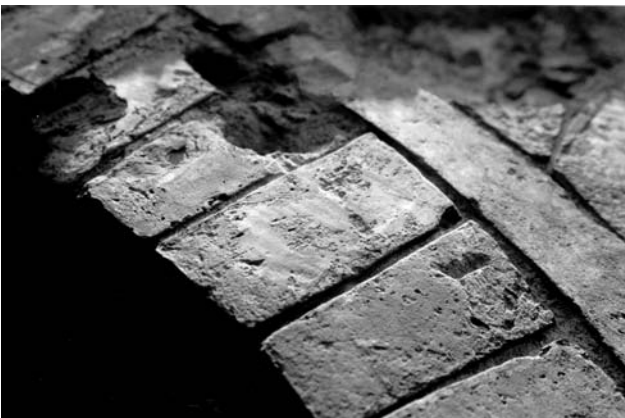
Fig. 7. Le tracce di una lisciatura ad essiccato lasciate da un coltello sui mattoni del coronamento dell'abside di San Romano (seconda metà del XIII secolo), Lucca.
